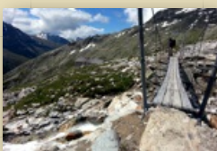
Eine Holzbrücke kurz vor der Olperer Hütte.*
