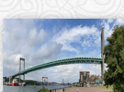
Die imposante Hängebrücke Älvsborgsbron nahe der Flußmündung des Göta älv in Göteborg.
