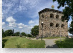
Der schweißtreibend Weg hinauf auf den Skansen Kronan garantiert einen tollen Ausblick.
